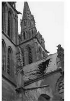
La collégiale de Munster a été sévèrement touchée par la tempête de décembre 1999. Photo d'archives RL
