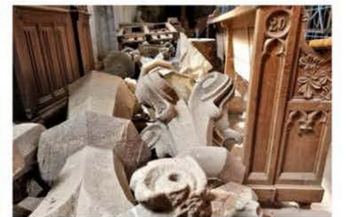
Les pierres d'ornements instables enlevées après la tempête de 1999 n'ont jamais été déposées faute de moyens. Photo Vincent Debraïne
