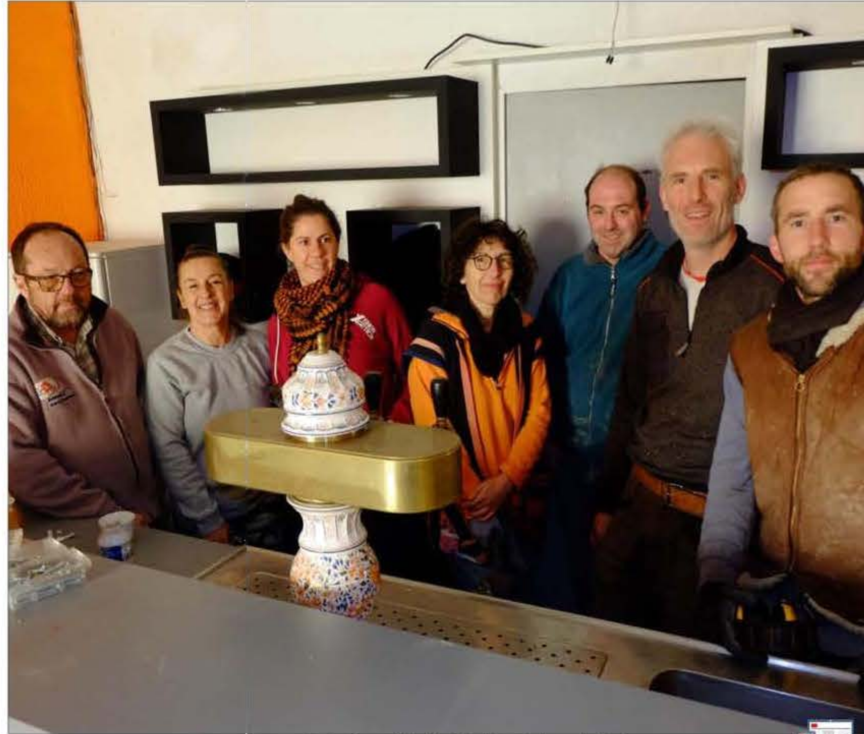
Le chantier participatif a débuté dans les locaux de l'ancien bar-restaurant La Lorraine à Dieuze. L'association y installera, d'ici mai-juin, son nouveau local avec un concept inédit dans le Saulnois d'épicerie de produits bio, café associatif et restaurant bio.
